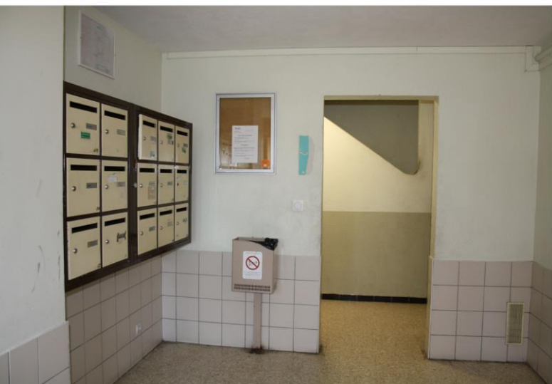
Hall d'entrée / Avant
