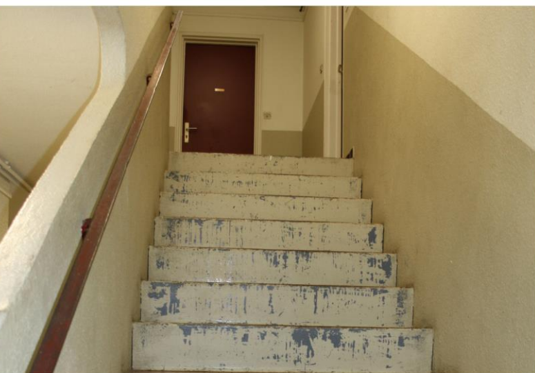
Cage d'escalier / Avant
