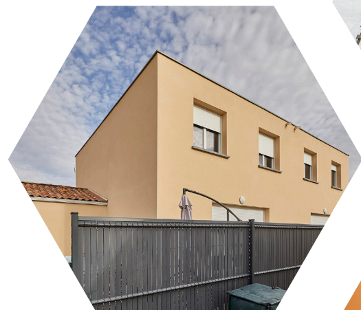
Cazouls les Béziers, Viva Villa 2 logements individuels
