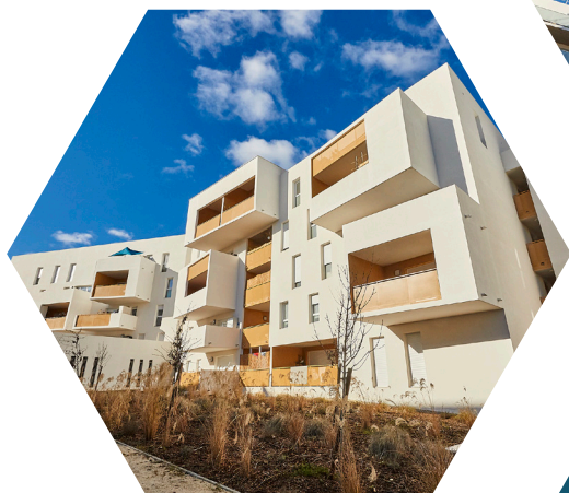
Montpellier, Albarelle 75 logements collectifs dont 30 HSS
