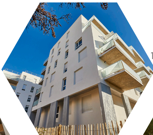
Montpellier, Sirius (tranche 2) 58 logements collectifs dont 31 HSS
